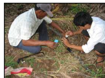
Verbindung der Versorgungsleitung am Feld
