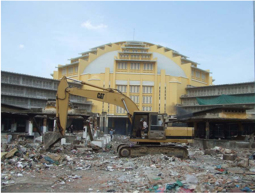
Der Zentralmarkt in Phnom Penh bei der Erneuerung
