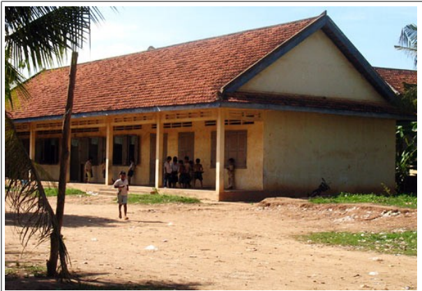
Schulgebäude in Kdey Chas
